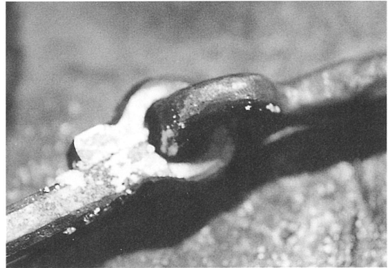
写真42 引手部分の連結
