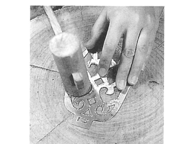
写真9 反った透し板を修正する
