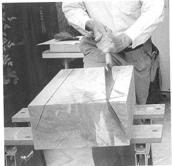
写真7 居木製作 外側加工(2)
