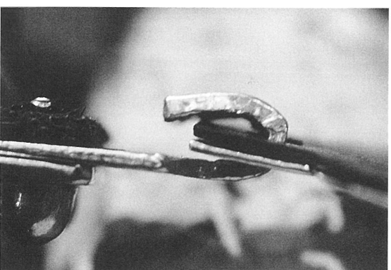
写真15 連結後の吊金具
