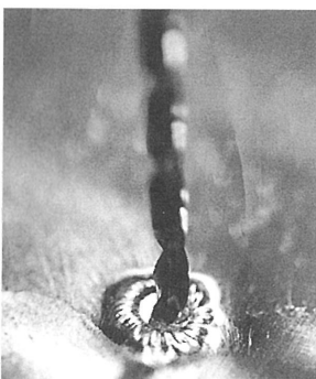
写真13 ドリルで孔加工する
