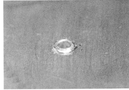
写真30 固定されたパイプ（裏側）
